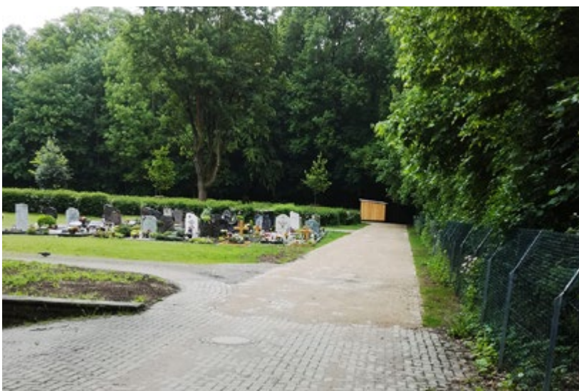
Die Friedhofswege wurden saniert und die Sammelstellen an die Südseite verlegt.
